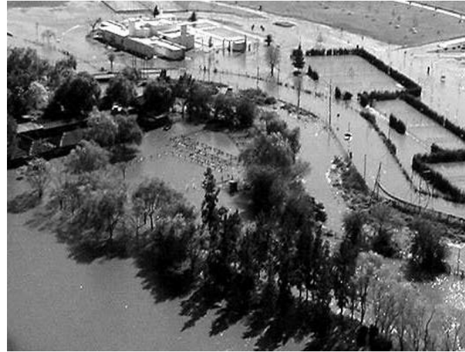
Sede Social de La Lomada de Pilar rodeada de agua, 18/4/02 Diario La Nación, pág. 16
